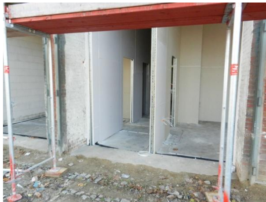
Haus 2 Innenansicht mit den neu gezogenen Zwischenwänden und Außenansicht
