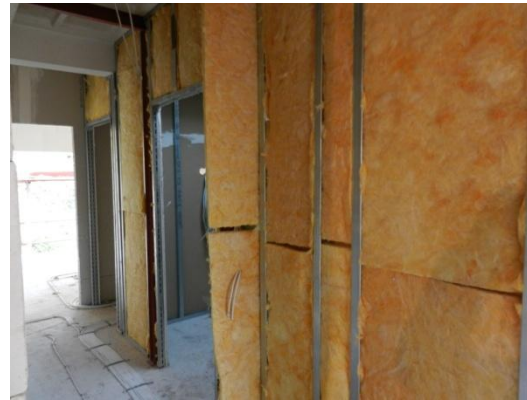
Haus 2b Verlegearbeiten von Strom und Wasser, Dämmarbeiten und die Außenfassade wird verklindert
