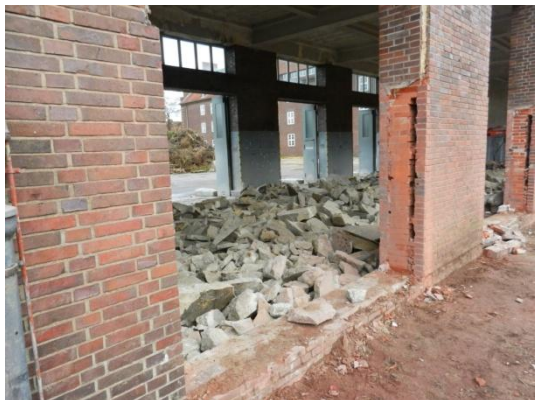
Haus 12 Entkernungsarbeiten
